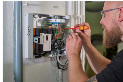
Die Installation der für das Monitoring erforderlichen Messtechnik erfolgt minimalinvasiv
