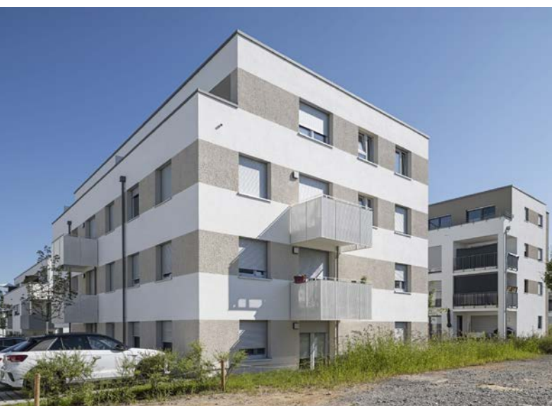
Bei diesen Neubauten der Städtischen Wohnungsgesellschaft Waiblingen ist eine digitale Anlagenerfassung und -steuerung bereits integriert
