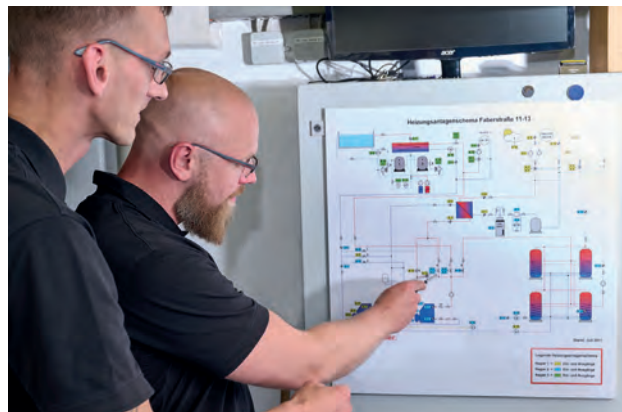
Digitale Nachrüstung macht Optimierungspotenziale in Heizungsanlagen sichtbar
