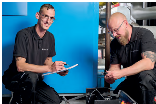
Immoconn-Heizungsbauer installieren die Mess- und Gateway-Technik für die digitale Zustandsanalyse im Heizungskeller
